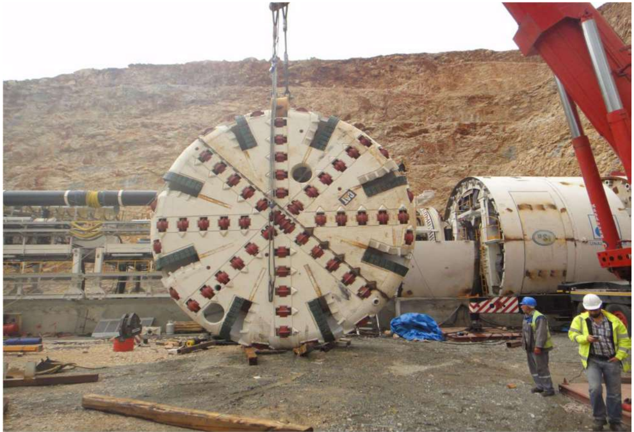
Şekil 5: Bir TBM'e ait kesici kafa
