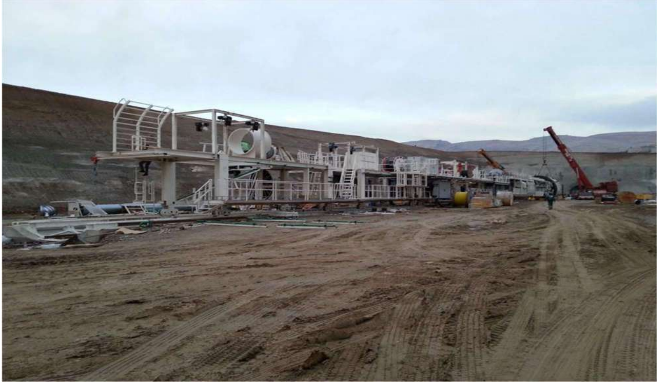
Şekil 17: Kurulum aşamasında bir TBM
