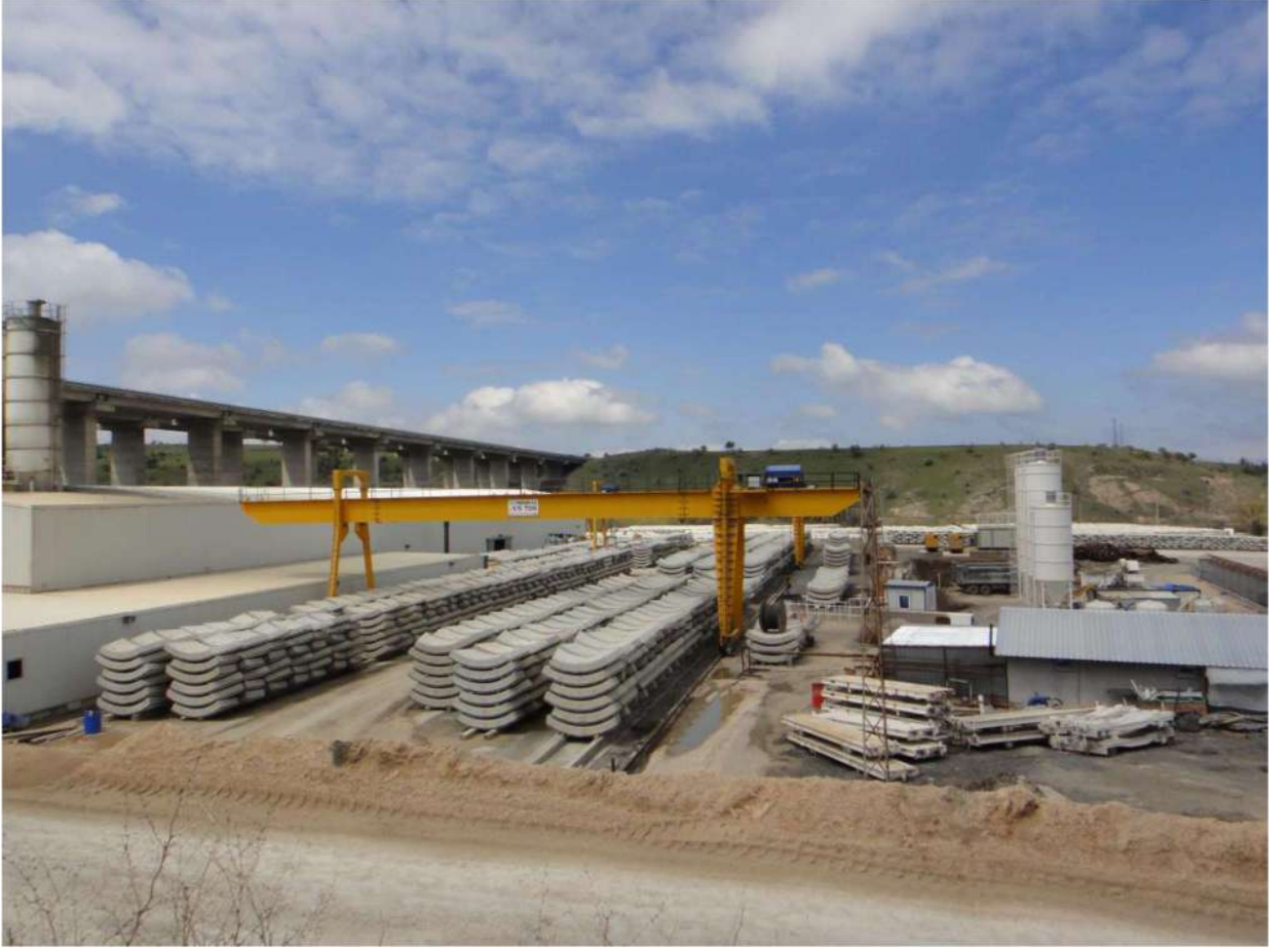
Şekil 32: TBM Portal sahası
